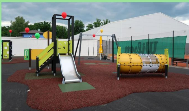
Pro zvýšení odolnosti povrchu jsou exponovaná místa vyztužena pryžovou dlaždicí (výjezd ze skluzavky, pod houpačkami, ...)
